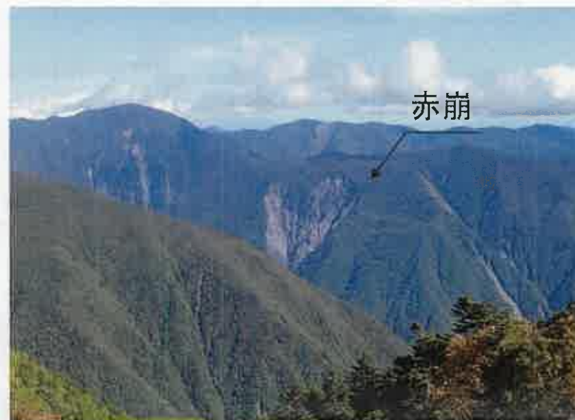
写真：赤崩 崩壊地は拡大を続けている
