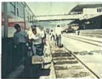
〈復旧作業の様子〉
