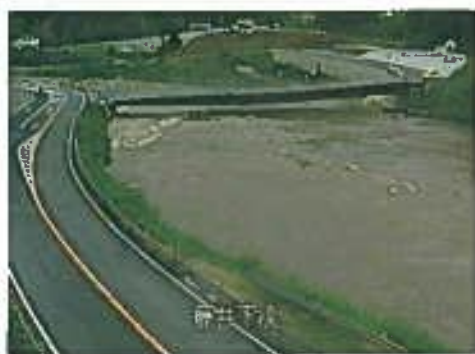
（平成26年台風11号の影響（大和川・王寺町））
