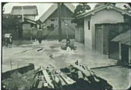
〈田原本町法貴寺付近の被害の様子〉
